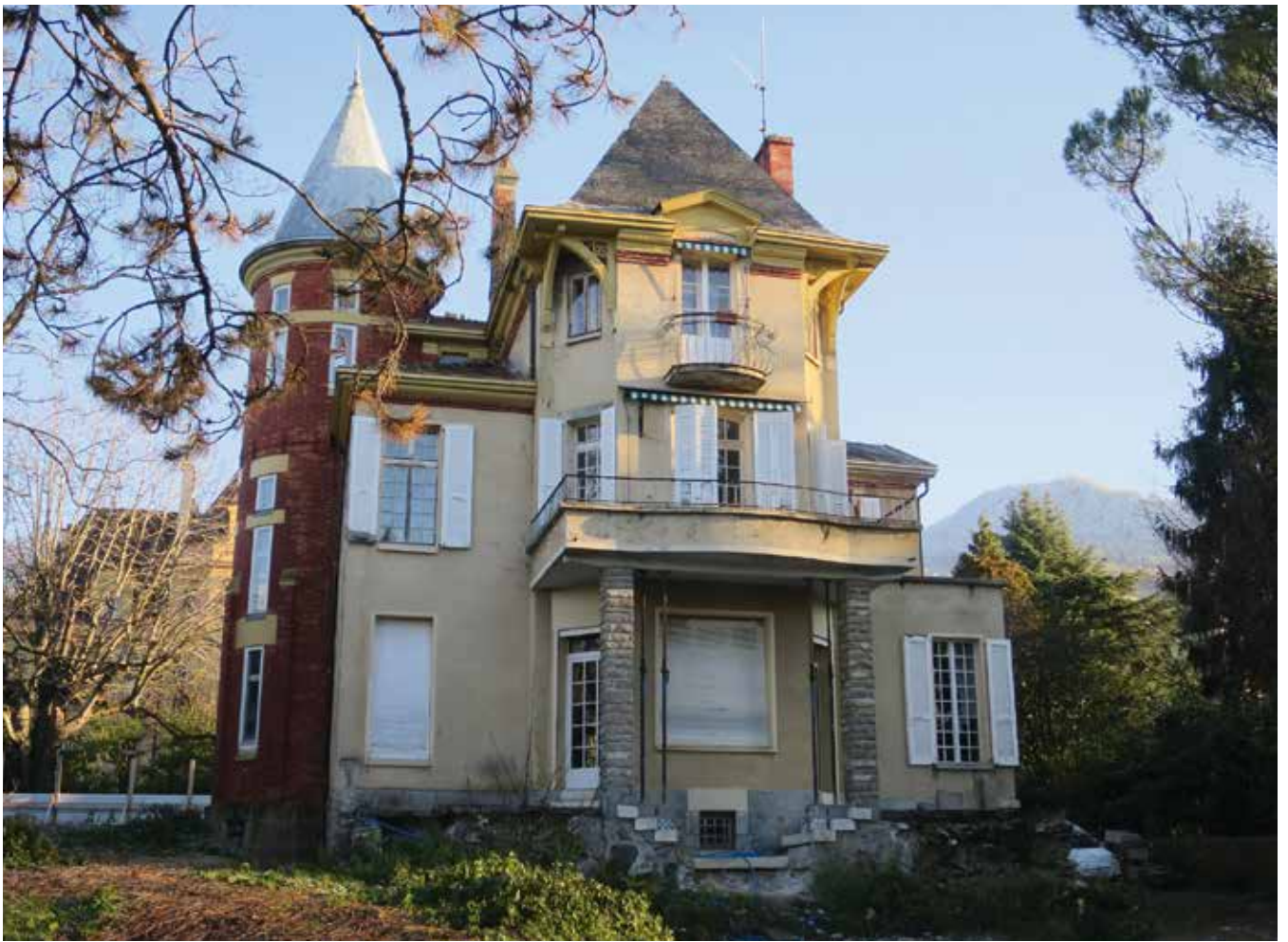
La villa avant restauration. Au premier plan, le balcon ajouté sur deux piliers disgracieux. Les balconnets en bois ont été supprimés.
