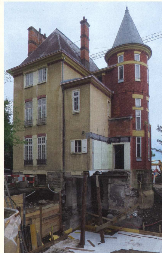
Reprise en sous-œuvre de l'angle de la villa pour l'extension nord, 2016.
