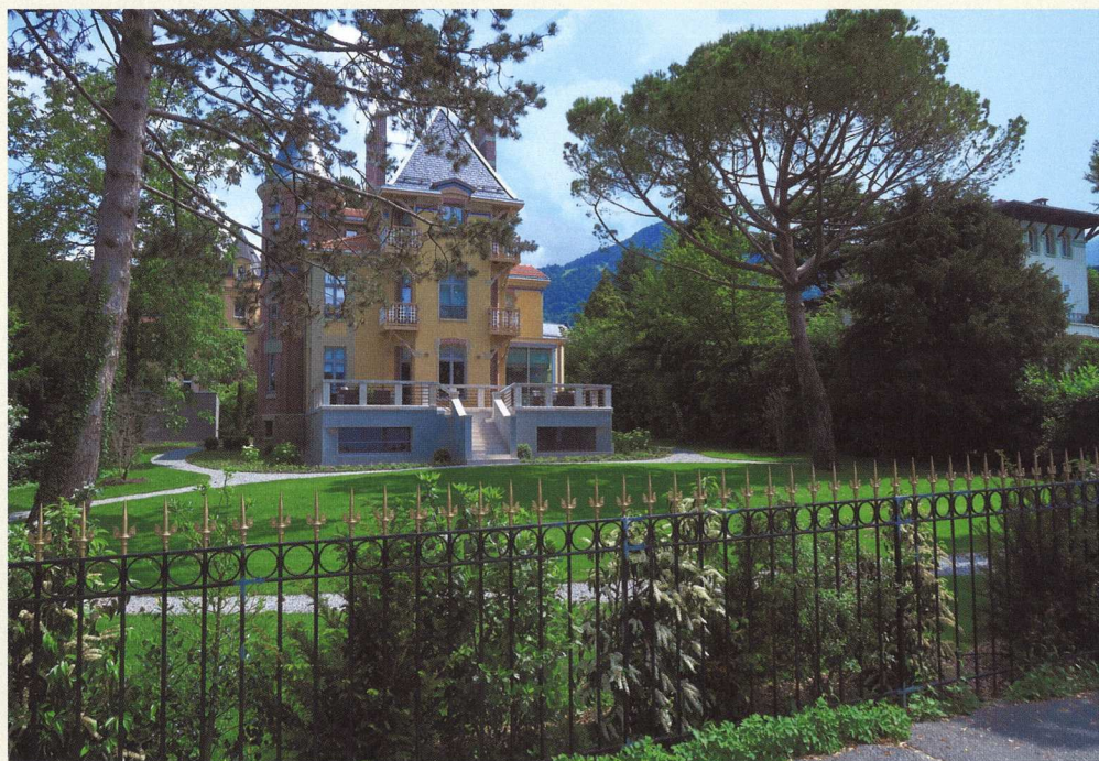
Vue générale depuis le sud, après restauration, 2018
