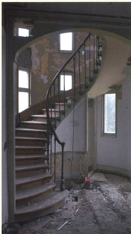
La cage d'escalier avant restauration, après les premiers démontages et sondages, 2016.
