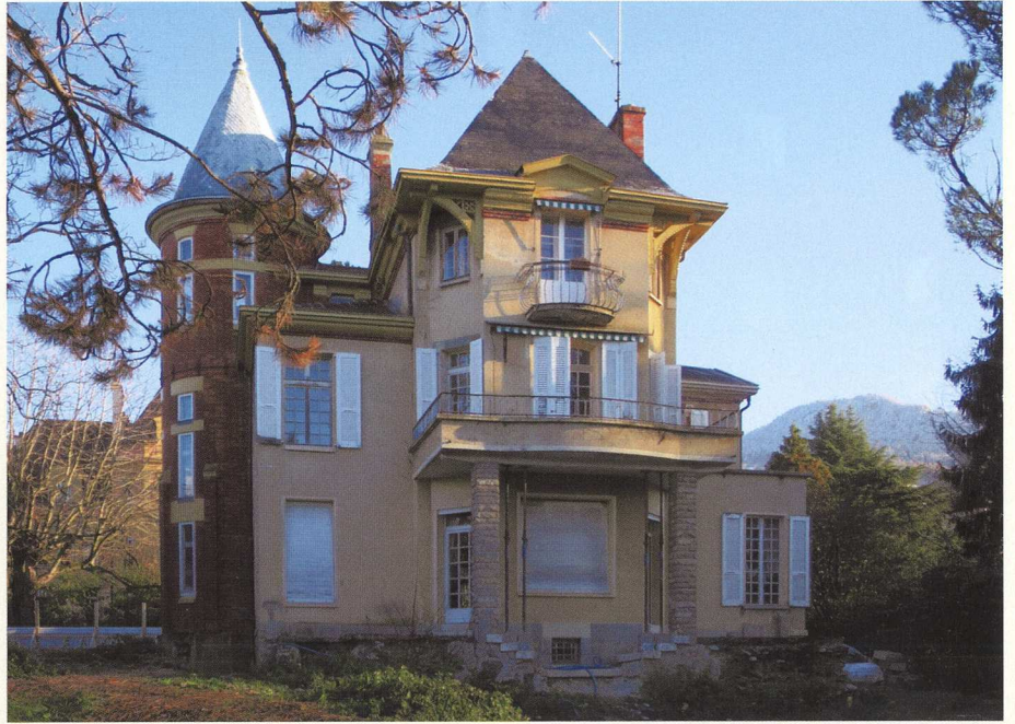
Vue avant travaux depuis le sud-ouest. Balcons tardifs en béton, 2015.
